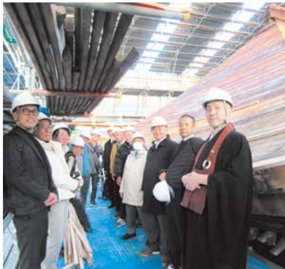
仏殿の修復現場
